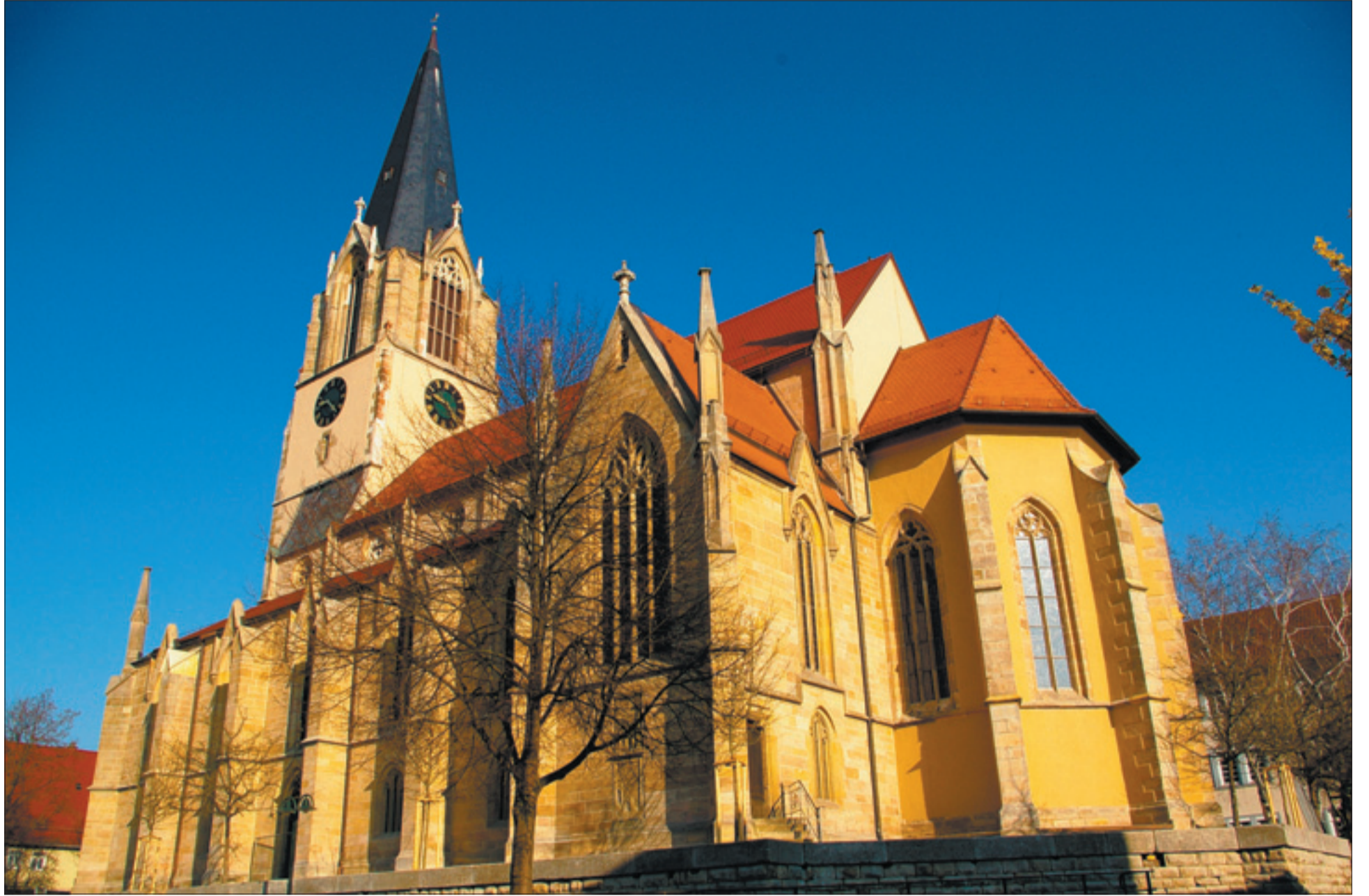
Nicht umsonst wird die Möhringer Martinskirche auch „Filderdom“ genannt. Nach der Sanierung erstrahlt das Gotteshaus wieder in seiner alten Schönheit.
