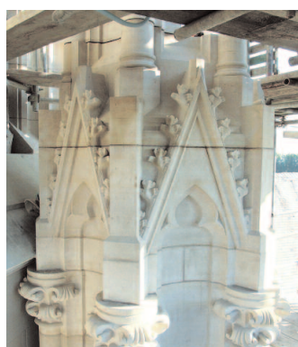
Südturm, 3. Wimpergzone: Zustand vor und nach der Restaurierung
