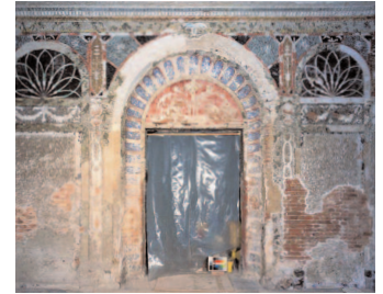
Grotte Neuer Garten Mittelsaal: Ostwand nach Sicherung der Grottenreste aus farbig hinterlegtem Marienglas, Raseneisenstein u.v.m.
