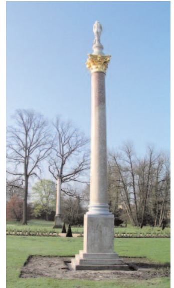
Die Korallenmarmorsäulen in Sanssouci konnten vor Ort restauriert werden.
