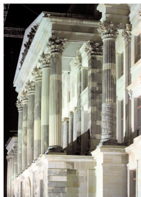
Am Portikus der westlichen Hauptfront wurden hauptsächlich Originalteile verbaut.
